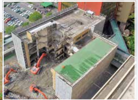
旧校舎解体工事 (2007年6月)
