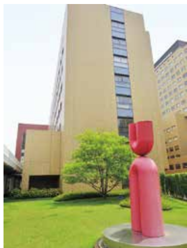
外観（西側より）
