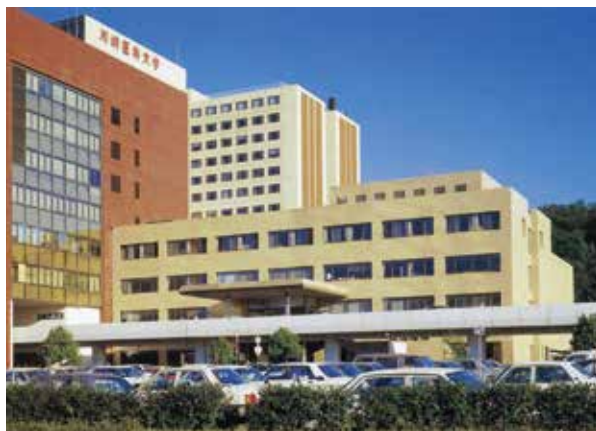
旧学院校舎棟（4階部分）
