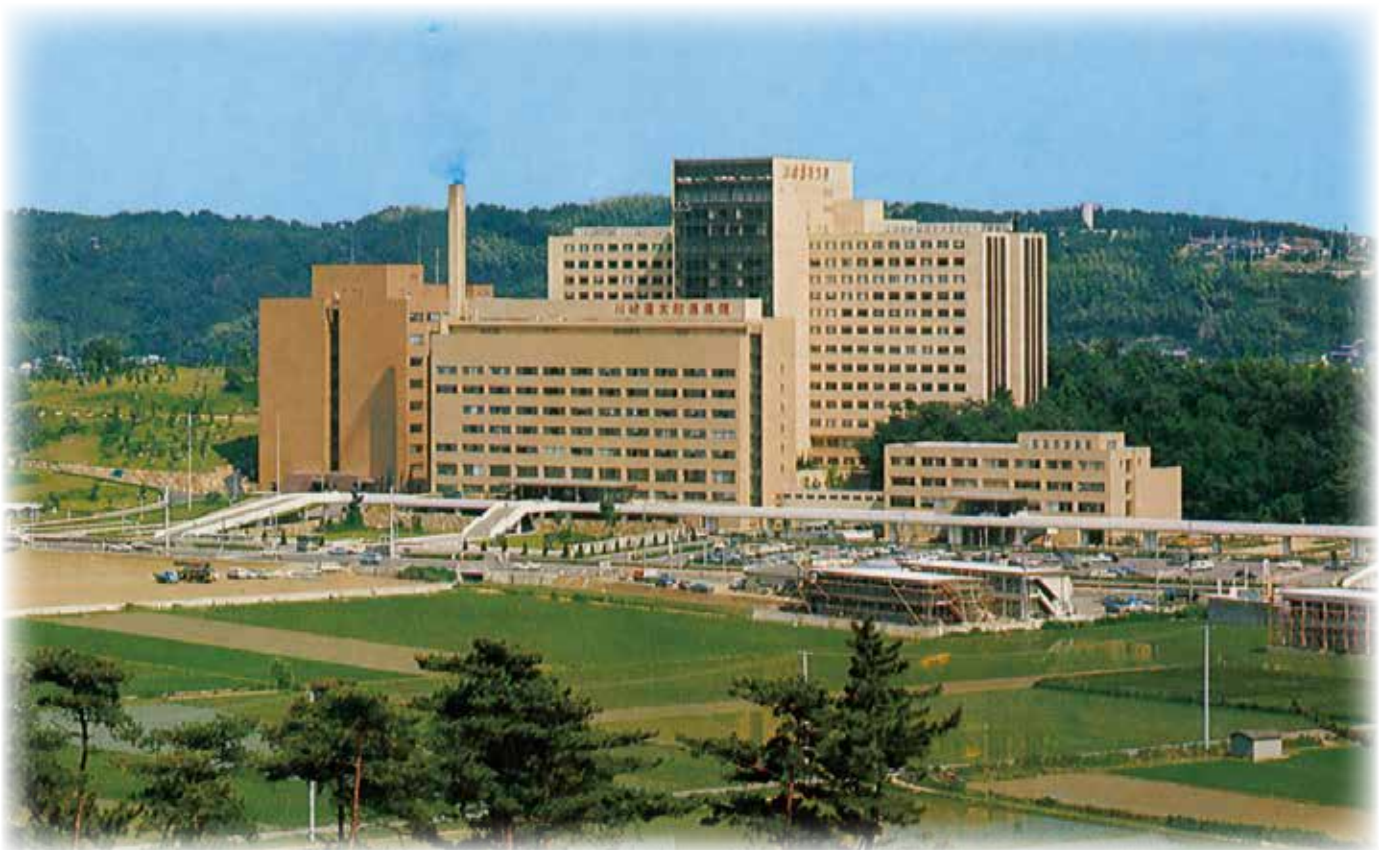
川崎リハビリテーション学院校舎竣工（附属病院西側）
